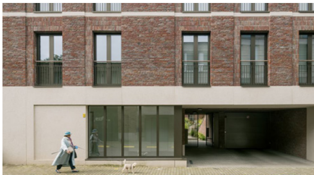
Herkenbare entree parkeergarage
