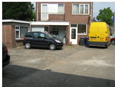
Foto 2: Achterzijde woning met uitbouw
