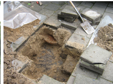
Foto 6: Vrijgegraven tank en mandeksel
