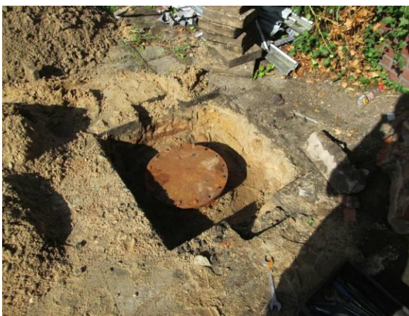
Foto 4: Mangat 20.000 liter gasolietank
