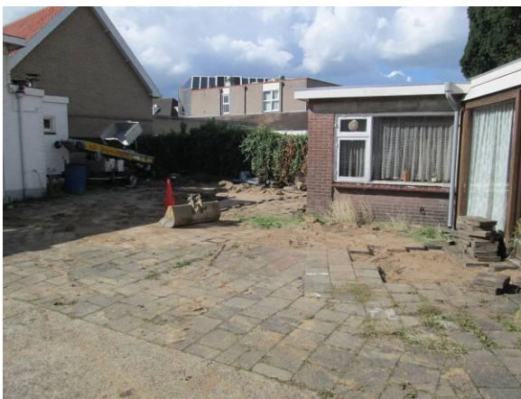
Foto 10: Aanvullen en verdichten ontgravingen en herstel straatwerk (2)
