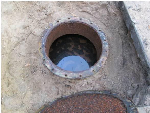
Foto 5: Inhoud 20.000 liter gasolietank
