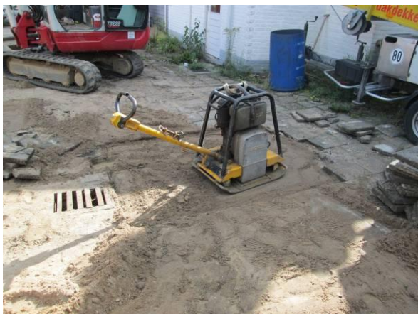
Foto 9: Aanvullen en verdichten ontgravingen en herstel straatwerk (1)
